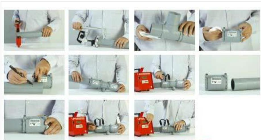
**Figura 4.34.** Proceso de montaje de tubería de PB por electrofusión.
