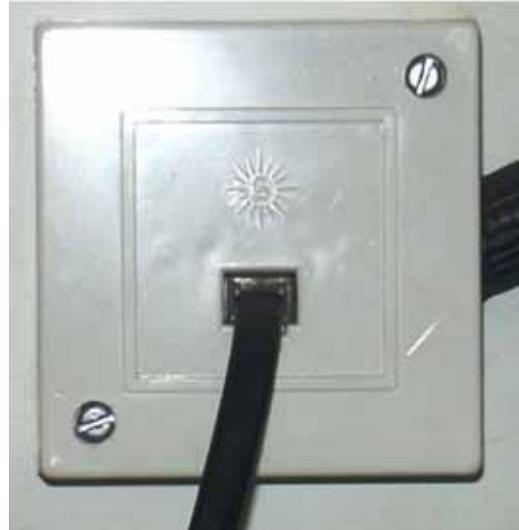
**Figura 10.13.** Base de acceso terminal utilizada en telefonía.
