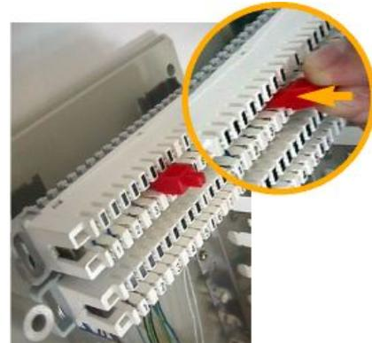
Separación de las señales de entrada y salida.
