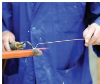
Figura 2.22. Trabajo con soldadura fuerte.
