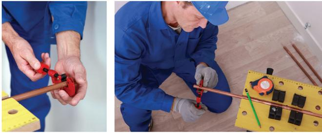
Figura 2.17. Cortado de tubería con cortatubos.
